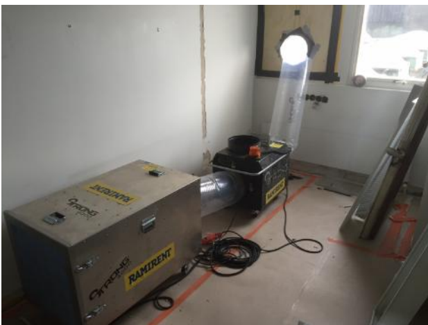
Laitteet asennettuna TYKS hankkeessa, ja paineentasaimen toteuttaessa 17 Pa alipaineasetusta 7% ulospuhalluksella
