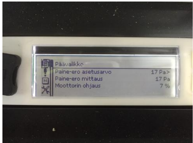
Laitteet asennettuna TYKS hankkeessa, ja paineentasaimen toteuttaessa 17 Pa alipaineasetusta 7% ulospuhalluksella
